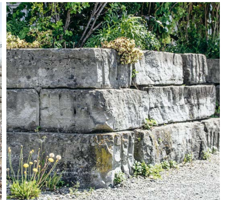
Stützmauer, Verbauungssteine maschinengespalten , Privatgarten Thal SG
