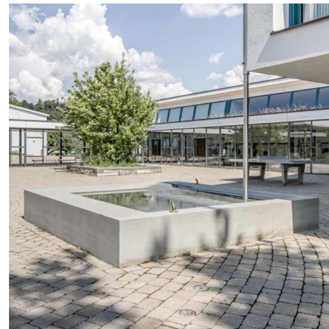
Brunnen einteilig, 2,8 x 2,8 m, Schulhaus Steinlig, Bassersdorf
