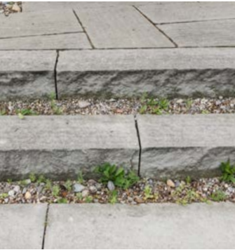
Stufenanlage, Blockstufen geschurt, Aussenraum Greifensee
