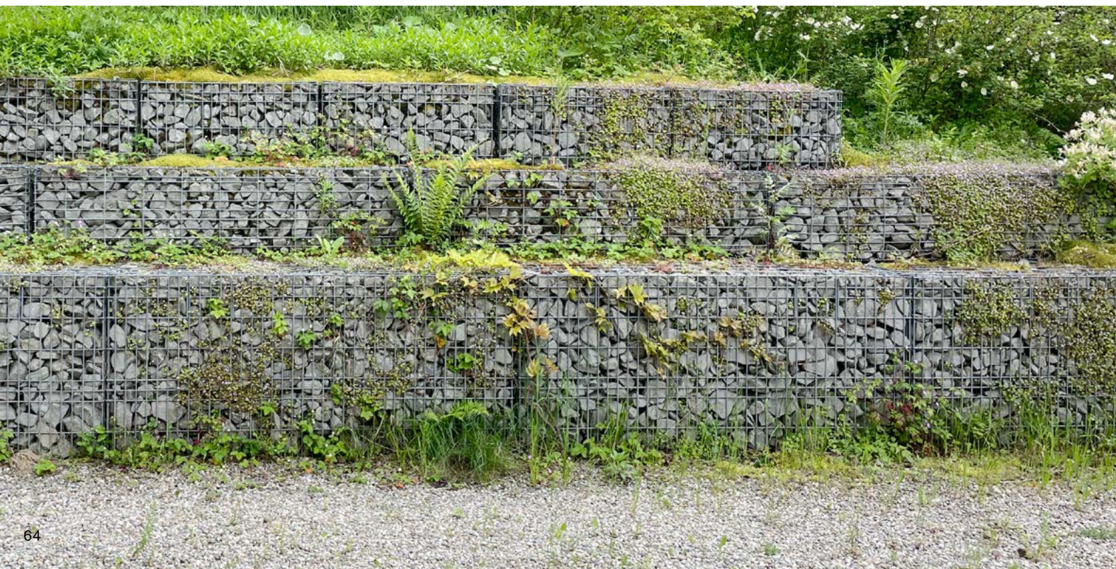
Stützmauer aus Schotterkörben Rorschacher Sandstein, Privatgarten Aadorf
