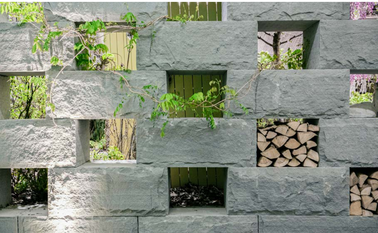
Sichtschutzmauer, Verbauungssteine handgespalten, Keilspuren entfernt , Giardina 2019, Zürich
