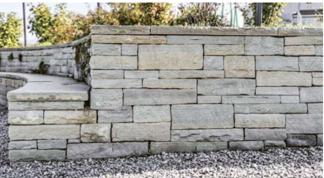
Sitzmauer aus Mauersteinen roh für Trockenmauern, Mostereimuseum Momö, Arbon
