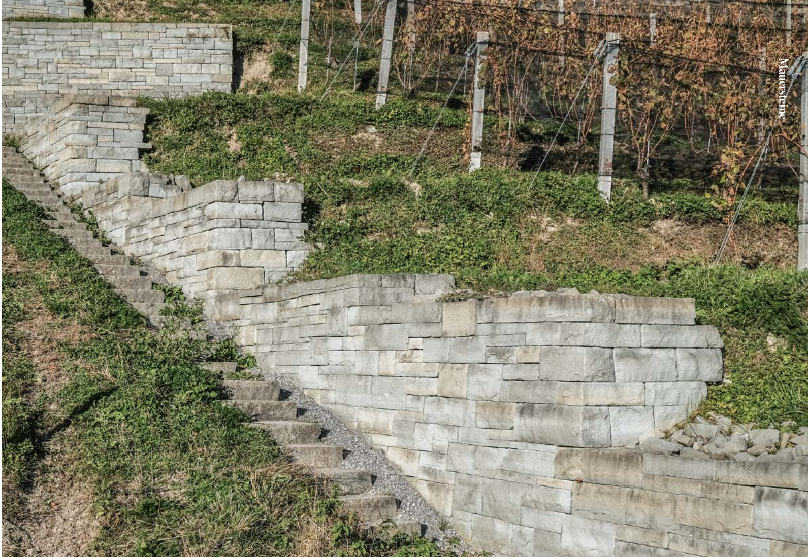
Trockenmauerwerk aus Mauersteinen roh für Trockenmauern, Rebberg in Thal SG
