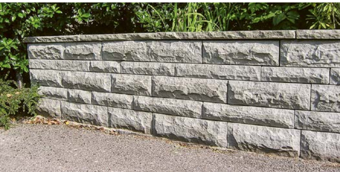
Stützmauer aus Mauersteinen gerichtet, Privatgarten
