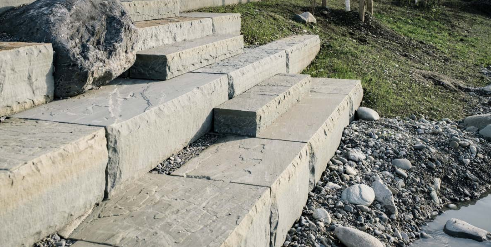
Flussrenaturierung, Verbauungssteine handgespalten, Keilspuren entfernt, Ouverture de la Drize, Genf
