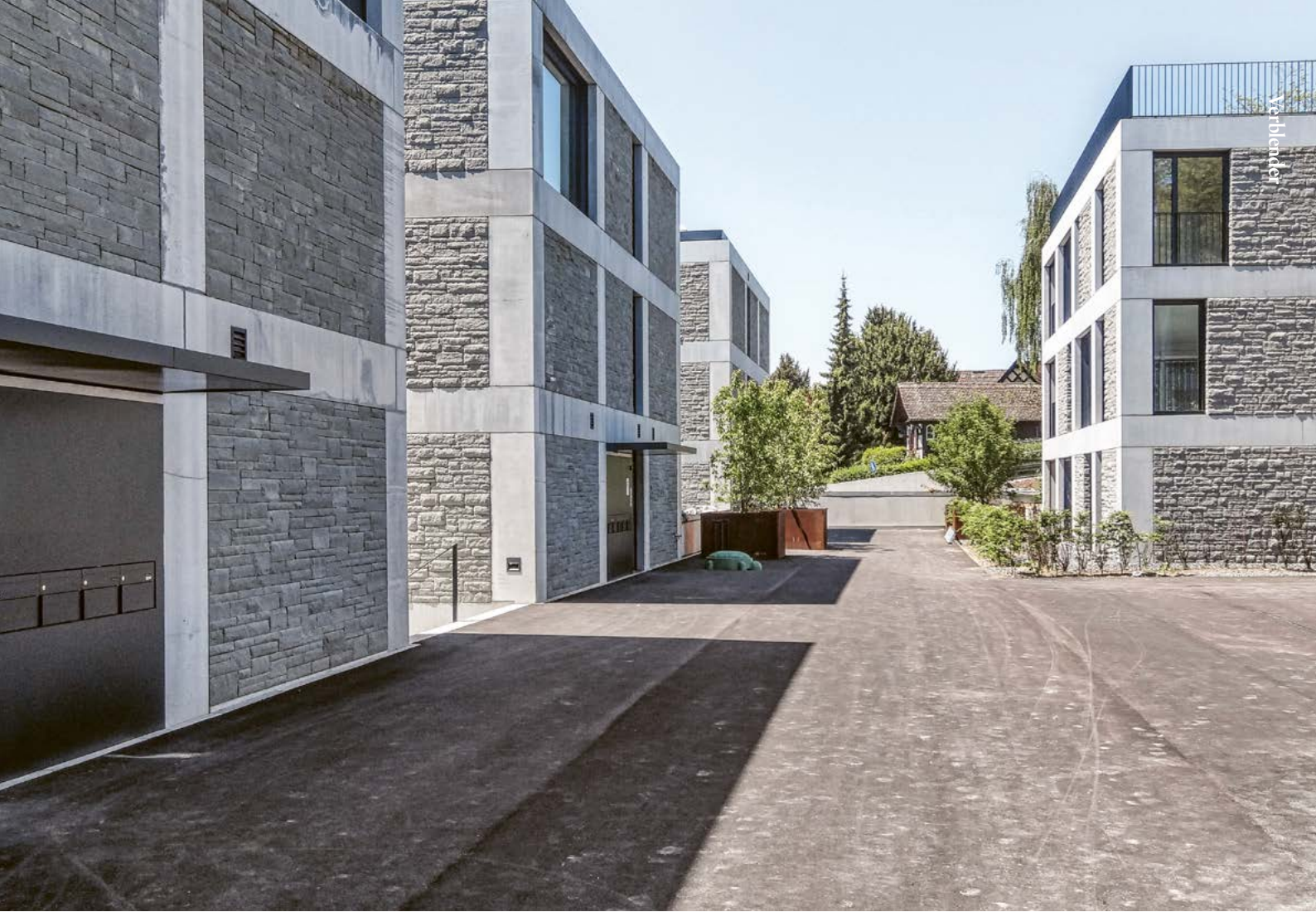
Sichtmauerwerk aus Mauer- oder Fassadenverblender , Wohnüberbauung Giessen, Meilen
