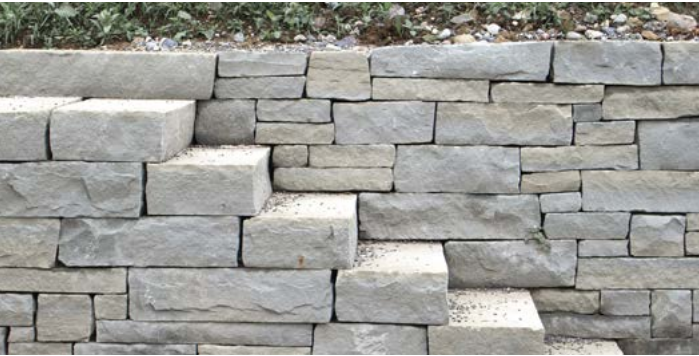
Treppe in Trockenmauer, Blockstufen geschurt, Privatgarten
