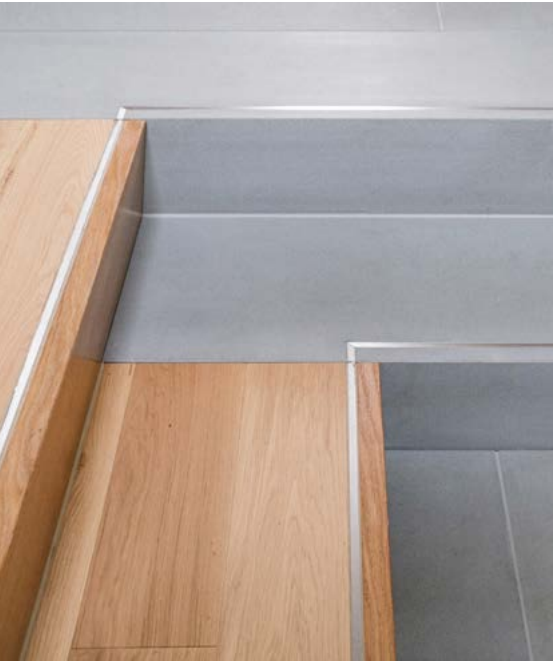
Bodenbelag, Bodenplatten geschliffen, Kirche St. Ulrich, Wittenbach
