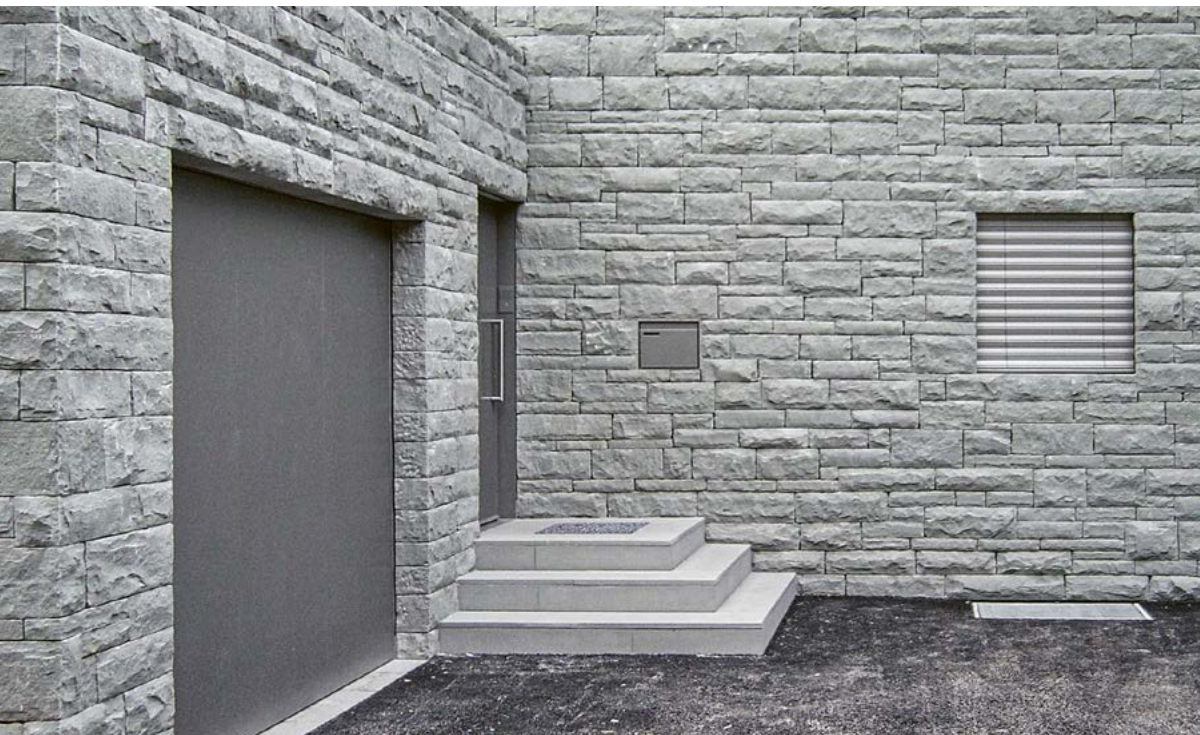
Sichtmauerwerk aus Mauer- oder Fassadenverblender , Privathaus, Lenzerheide GR
