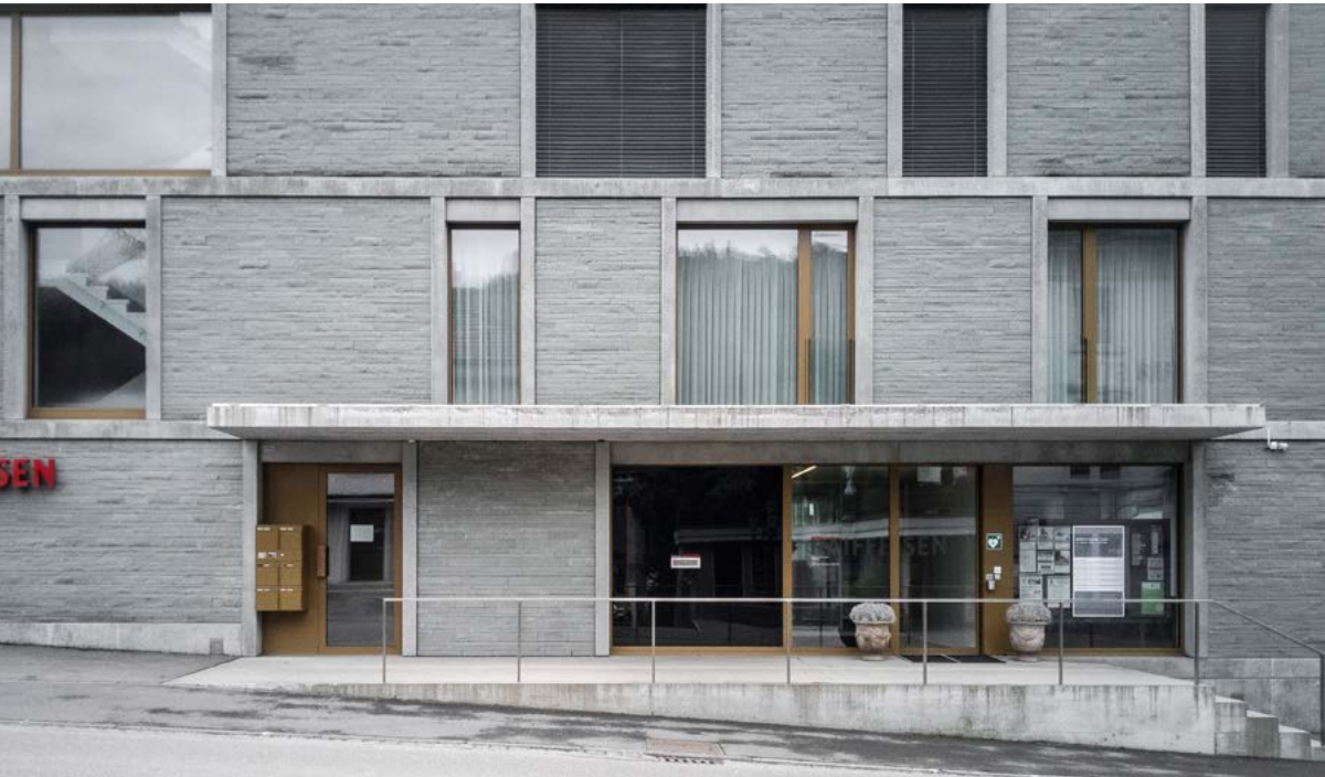
Sichtmauerwerk aus Mauer- oder Fassadenverblender , Raiffeisenbank, Ebnet-Kappel
