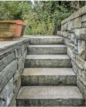
Treppe, Blockstufen geschurt, Villa Mon Repos, Aadorf
