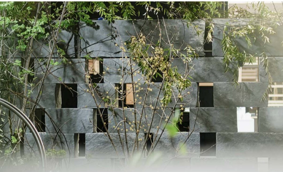
Sichtschutzmauerwerk aus Mauersteinen roh gespalten, in fixen Schichten , Giardina 2025, Zürich
