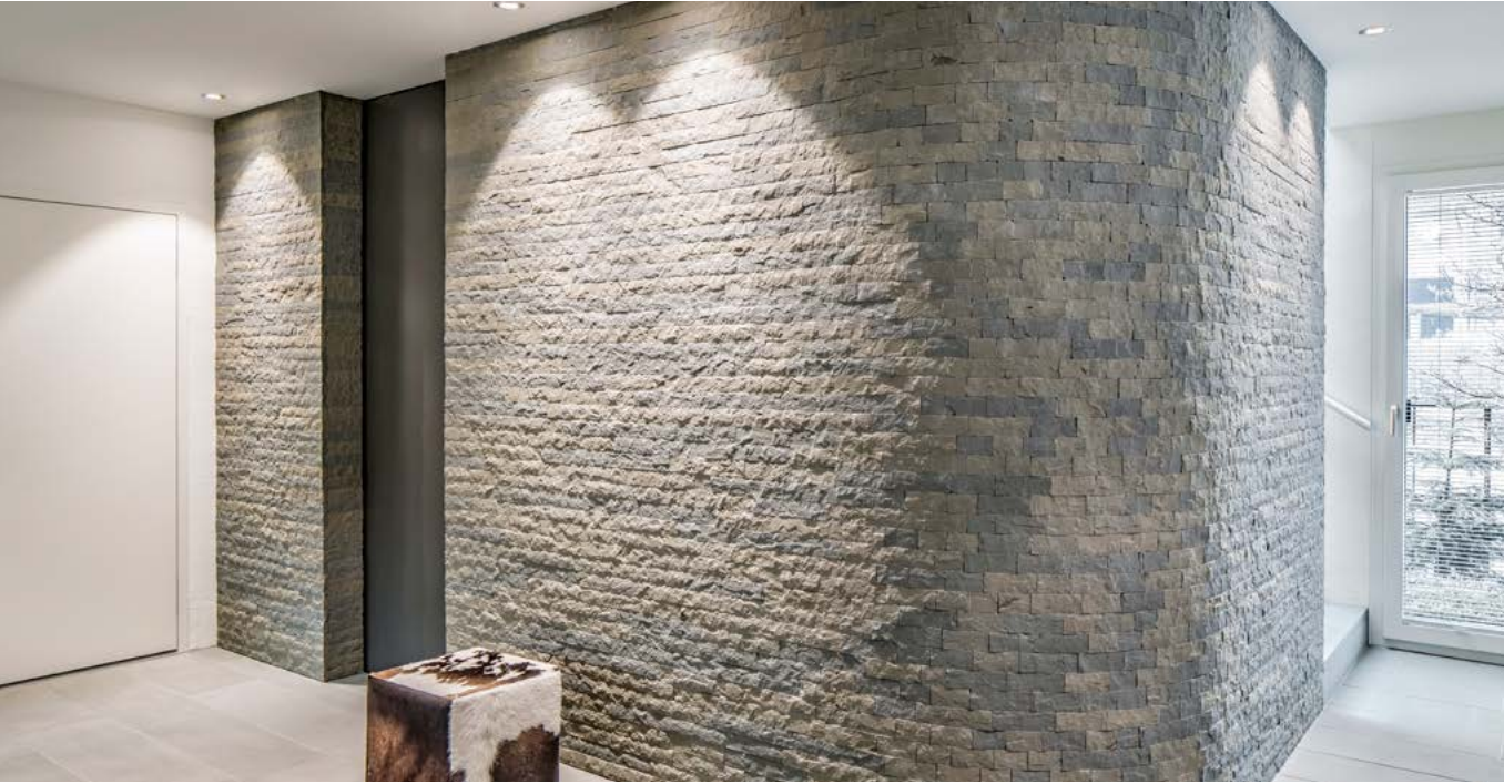
Wandverkleidung im Innenbereich aus Verblenderriemchen gespalten , Privathaus, Altstätten SG
