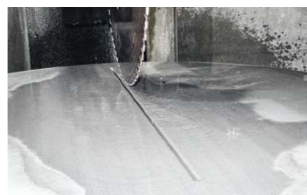
11 Danach erfolgen die ersten Frässchnitte, um das Becken auszubilden.
