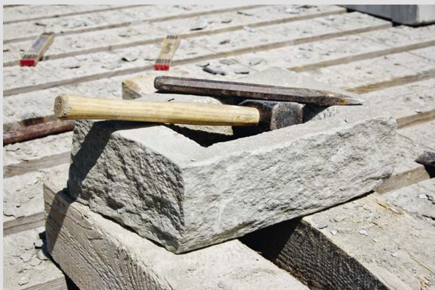
Bei Bärlocher arbeiten erfahrene Profis beim Bau von Trockenmauern.
