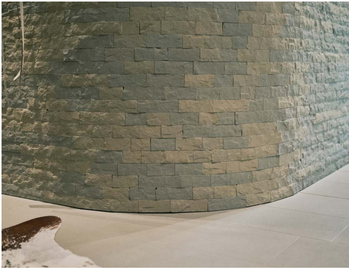
Rorschacher Sandstein als Bodenbelag und Wandverkleidung im Hauseingang: regional, warm, dauerhaft.
