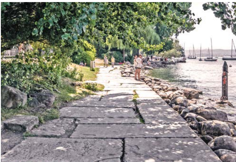
Die grossformatigen Platten des 230 Meter langen Seeuferwegs liegen nur 40 Zentimeter höher als der wenig schwankende Seespiegel. Mehr als zwei Drittel der Platten wurden im Steinbruch Bärlocher gebrochen und auf die exakten Grössen gerichtet.
