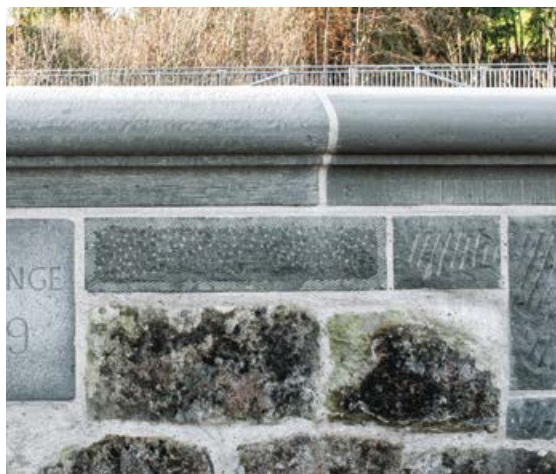
Flügelmauer mit Brüstung – alte und neue Steine wirken effektiv zusammen. Die Witterung wird sie im Laufe der Zeit wieder angleichen.
