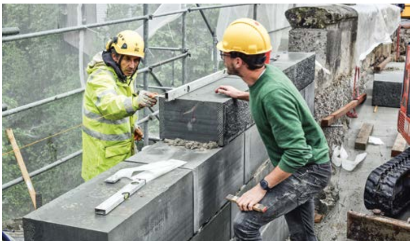
Das Versetzen von neuen Steinen bedingt hohe Sorgfalt.
