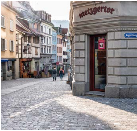
In der Metzgergasse entschied man sich für die gebundene Pflasterung, bei der die Steine durch Bindemittel verbunden sind.
