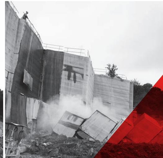
Es ist jedes Mal ein Erlebnis: Mittels moderner Bohrtechnik und Diamantseilsägen und unter Mitwirkung eines erfahrenen Teams wird der Rorschacher Sandstein sorgfältig und in klar bestimmten Etappen abgebaut.
